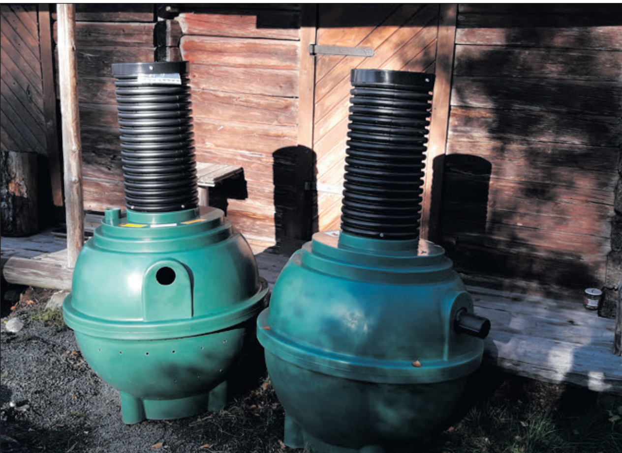
Rotomonin valmistamat säiliöt odottamassa maahan upotusta aitan edustalla.
